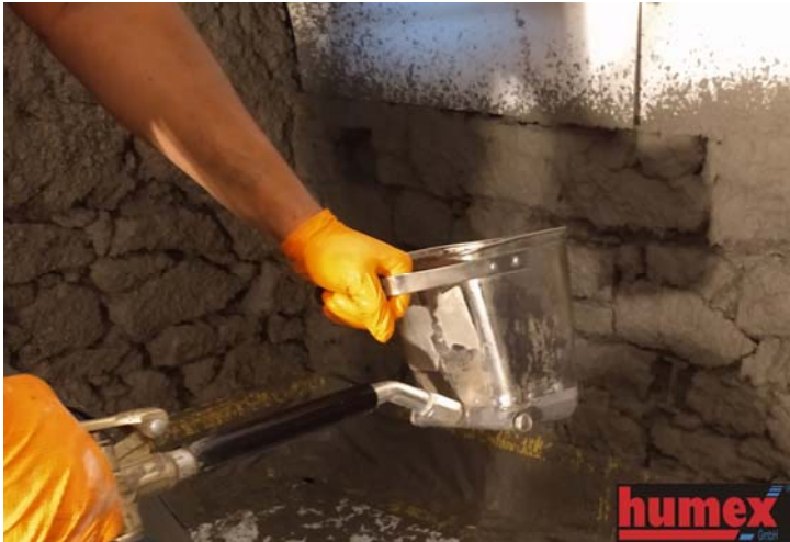
HydroCure® DC-920 bei Bruchsteinmauerwerk
